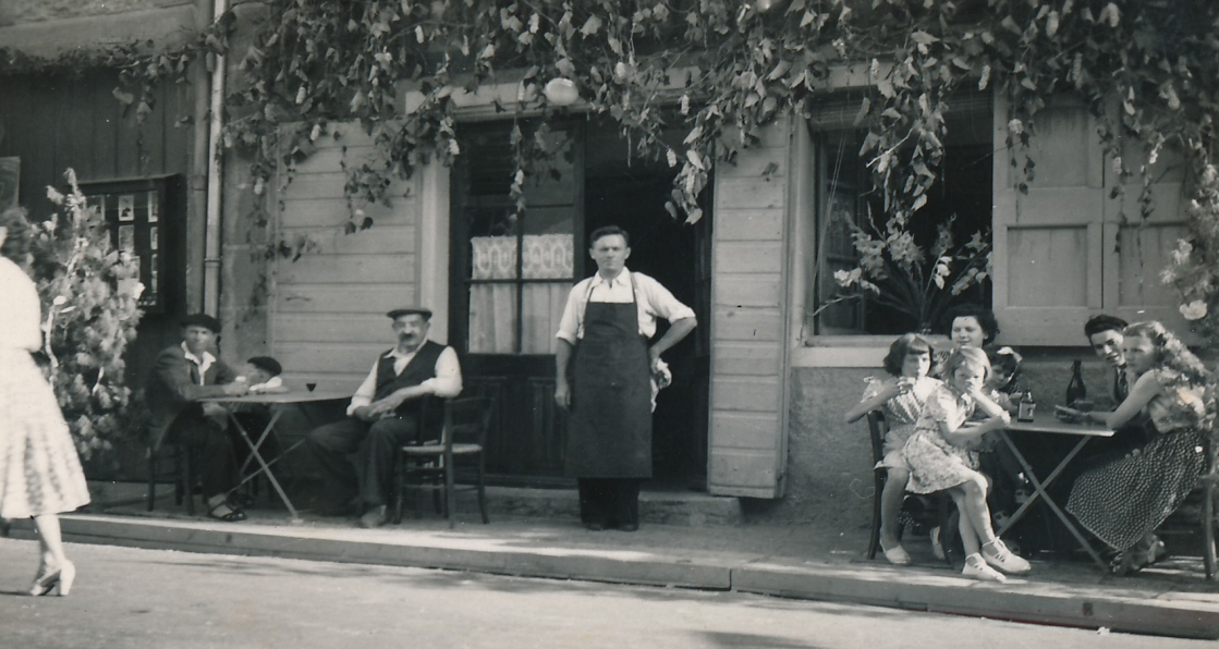
Été 1951 - Façade de l'hôtel-restaurant Ollard, grande rue.
